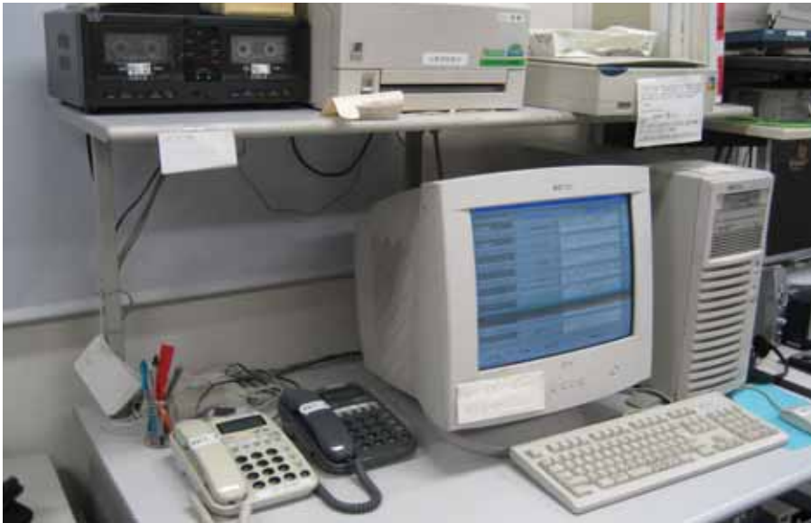
災害弱者消防緊急通報システム(山県市消防本部通信指令室内) 平成12年4月1日 運用開始
