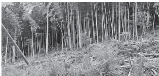
▲ 支障木の伐採後
