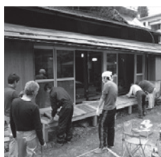
▲空き家リノベーション (田園移住支援事業)
