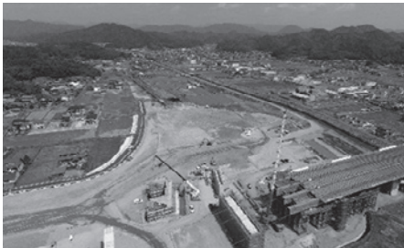
▲インター周辺工事進捗状況
