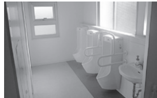
トイレ改修工事
