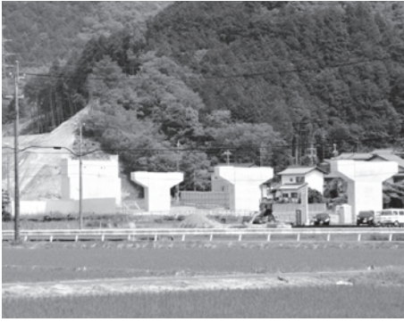
東海環状自動車道進捗状況
