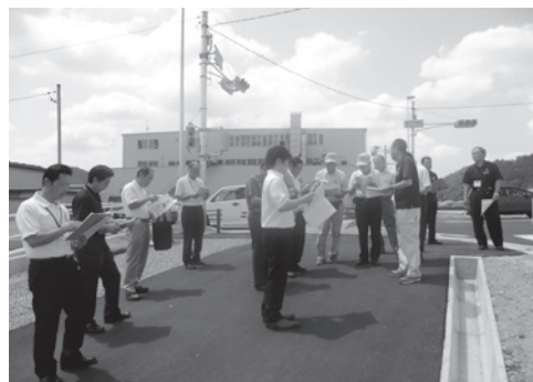
鳥羽川改修工事現場
