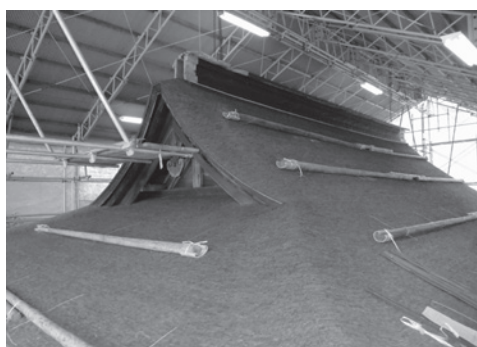
白山神社屋根葺替えの様子
