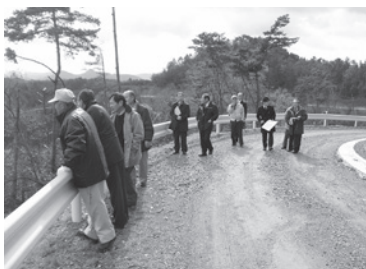
林道伊自良・根尾線工事現場
