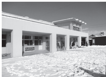
耐震補強工事をした高富保育園
