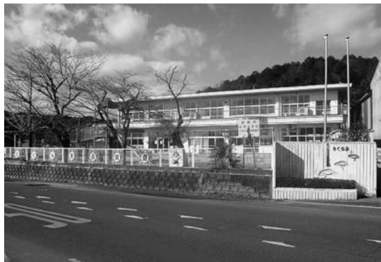
改修工事が行われる桜尾保育園
