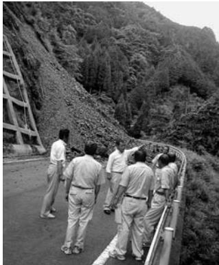
葛原地内土砂崩れ現場視察
