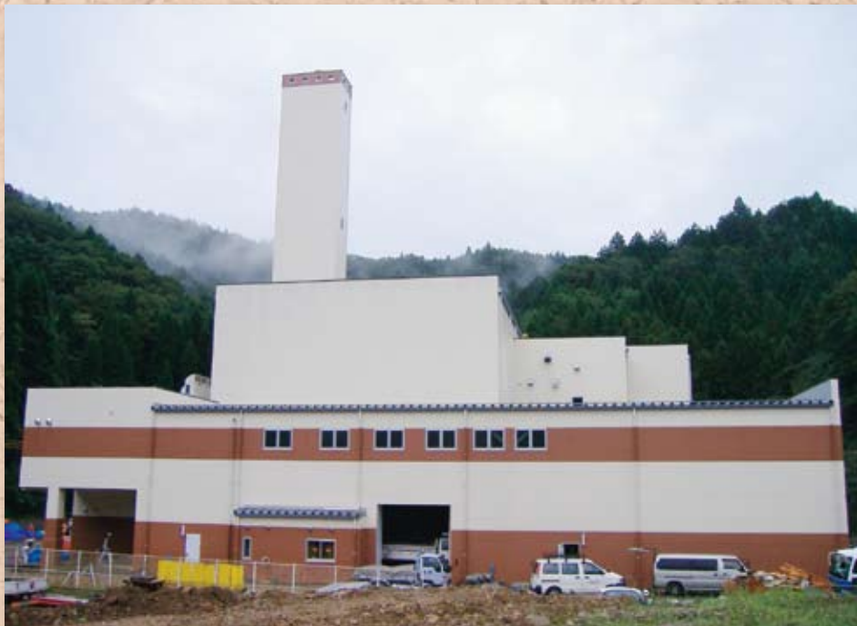
完成間近の (仮称)山県市新クリーンセンター
