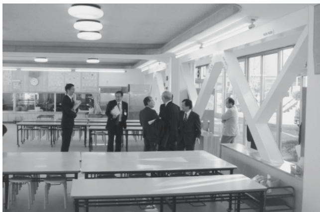
耐震補強されたランチルーム
