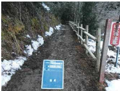
みやまの森木製転落防止柵
