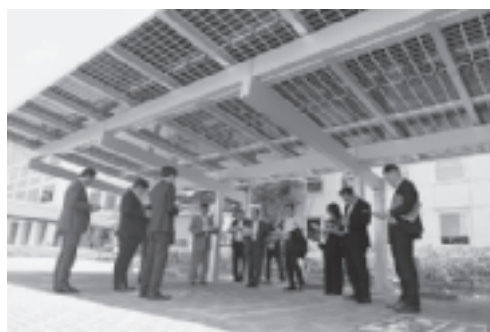
▲保健福祉ふれあいセンター南駐車場 ソーラーカーポート
