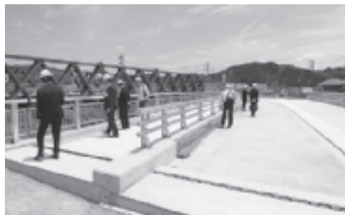
▲工事中の富岡橋
