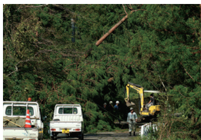
倒木被害、道路の寸断、停電
