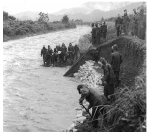
9.12豪雨災害での積み土のう工法
