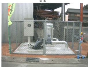
機械揚水機整備状況 (松尾地区)
