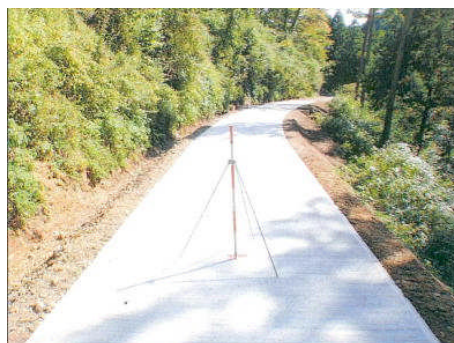
林道西洞～納谷舗装工事箇所の様子
