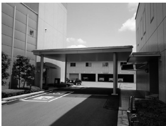
庁舎バリアフリー改修工事
