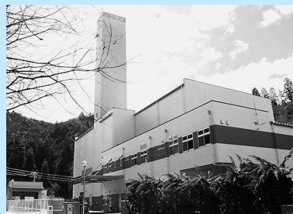
クリーンセンター完成
