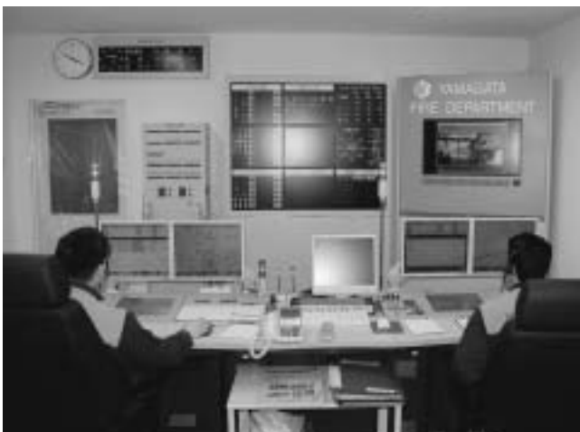
高機能消防指令センター
