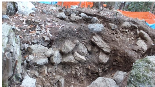
巨石列の背面造成
