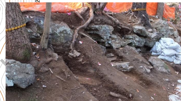
斜面側の石垣
