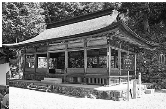
1 白山神社拝殿(東深瀬地内) 国指定重要文化財(建造物)
