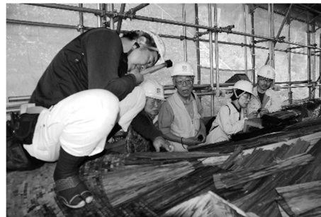
白山神社拝殿修復工事写真
