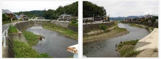
一級河川鳥羽川改修状況
